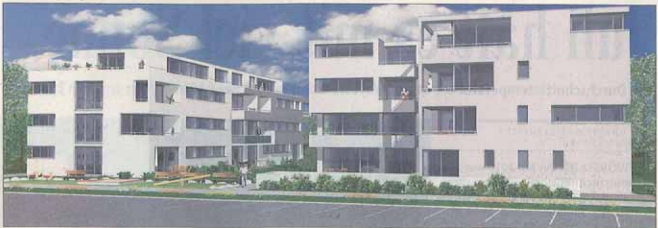
Blick vom Hallenbad aus: Hinter den neuen Parkplätzen die geplanten Gebäude, rechts daran schließt sich die Scheffelstraße an.
